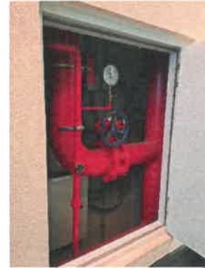
ระบบท่อขึ้นเพื่อรับน้ำดับเพลิงจากถังเก็บน้ำชั้นใต้ดิน B2
