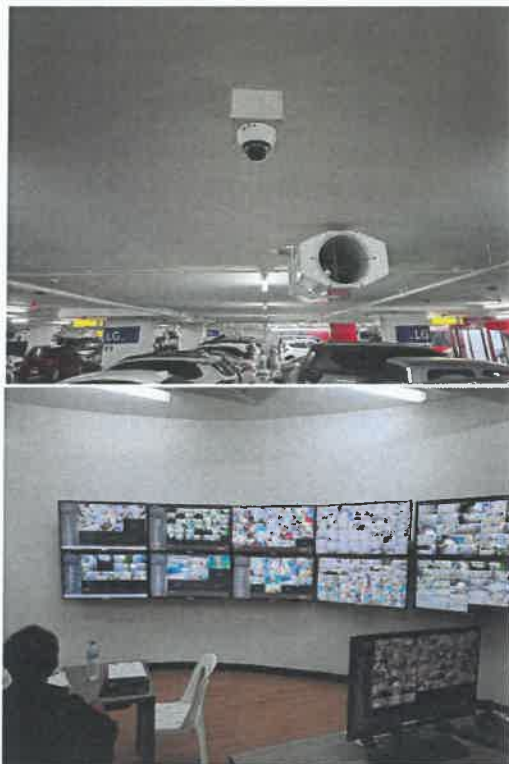
รูปที่ 41 ระบบโทรทัศน์วงจรปิด (CCTV System)
