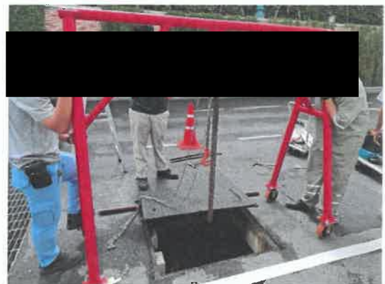
รูปที่ 52 การตรวจสอบเครื่องสูบน้ำภายในบ่อท่ว่งน้ำ
